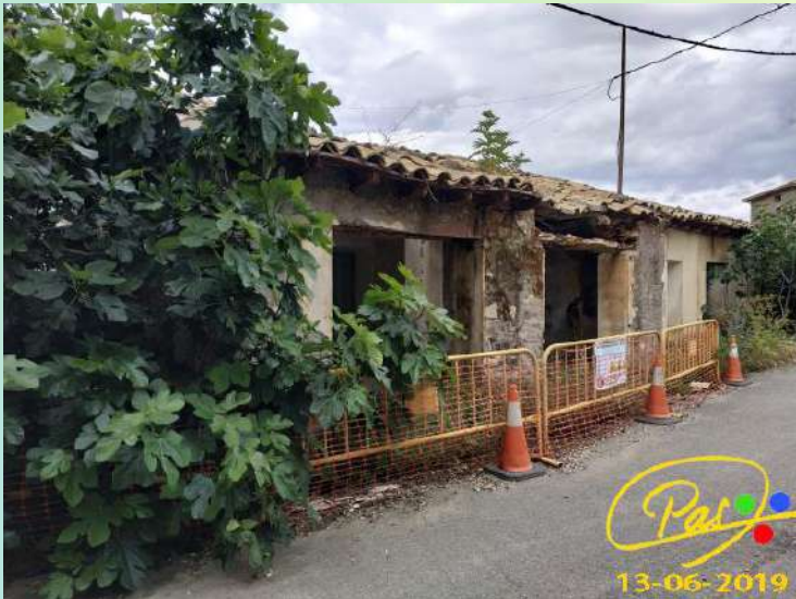
Obras en la escuela
